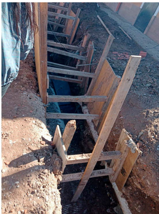
Imagen 14: Obras en el barrio 8 de Mayo. Fuente: Fotografía propia (2023)
