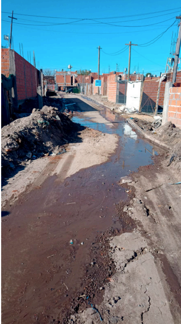
Imagen 15: Pavimento nuevo en barrio 8 de Mayo. Fuente: imagen propia (2023).
